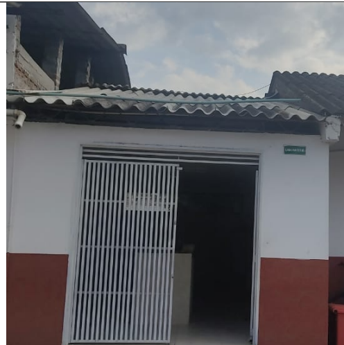
Arreglo del techo laboratorio Sede Miguel Antonio Caro
