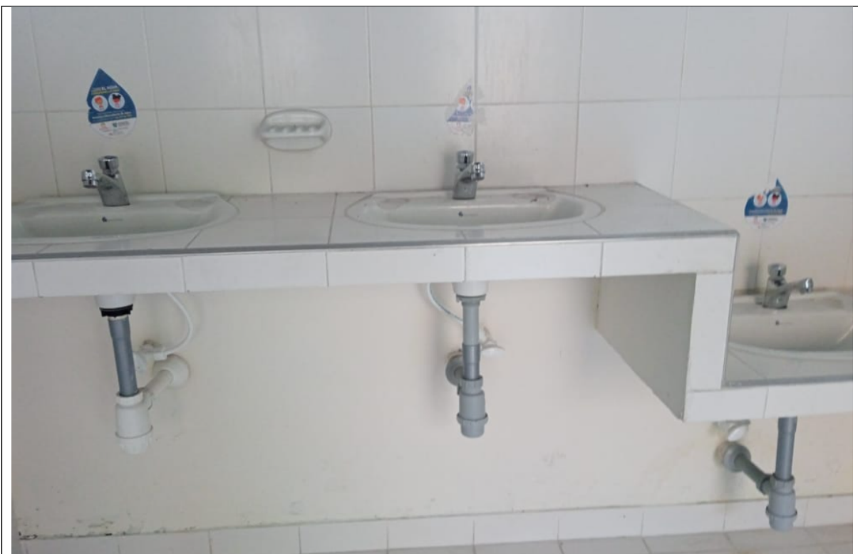
Reparacion de griferia baños, sede Francisco José de Caldas.
